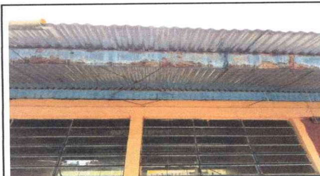
Foto 5: Colocacion de canal de metal
