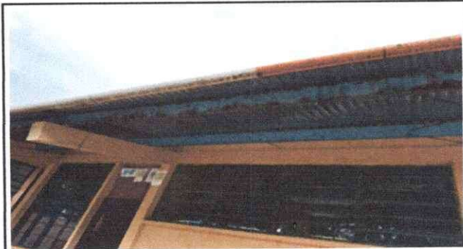
Foto 4: Cambio de canal PVC a canal de metal.
