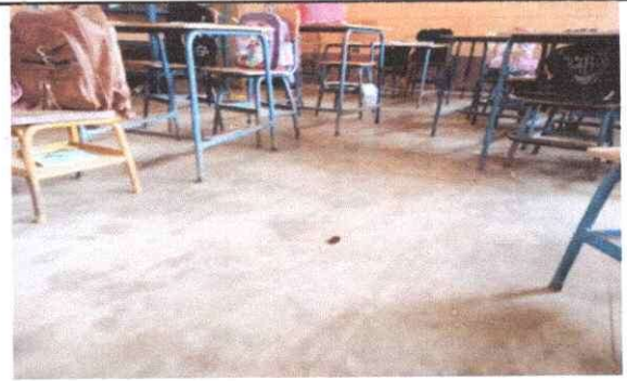
Foto 4: cambio de piso de torta a piso ceramico del aula de quinto, ya que sen encuentra en mal estado tiene al redor de 40 años de haberlo elaborado.
