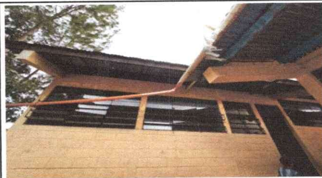
Foto 3: Cambio de canal PVC a canal de metal, si se mantiene el canal de PVC se arruina la lamina y crea un mal aspecto a las orillas de la lámina.
