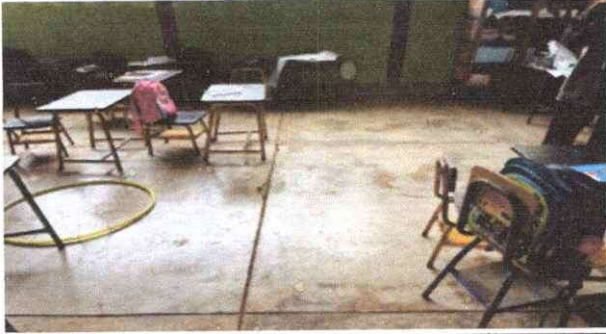
Foto1: Sustición de piso de torta por piso ceramico, del aula de primero ya que se encuentra en malas condiciones y se encuentra deteriorado
